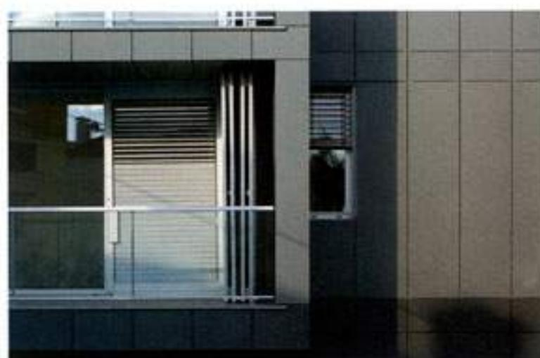
O PROJETO OBEDECE A UMA MÉTRICA MUITO PRECISA QUANTO À MODULAÇÃO DAS FAÇADAS E APlicaÇÃO DOS DIVERSOS MATERIAIS. ELE PARTE DE UM "MÓDULO" DE 0.60M (METADE DE 1.20 - DIMENSÃO DAS PLACAS DE GLASAL) QUE SE REPETE EM FUNÇÃO DAS NECESSIDADES DE CADA COMPARTIMENTO
